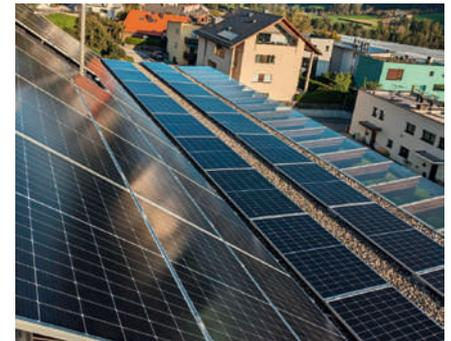
Die neue Photovoltaikanlage auf dem Rathaus hat eine Nennleistung von 20 kW
